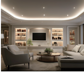
折り上げ (直線・曲線)
