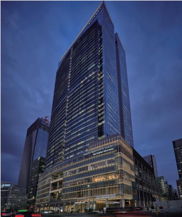
東京ミッドタウン八重洲 所在地：東京都中央区 基本設計・実施設計監理：株式会社日本設計 実施設計・施工：株式会社竹中工務店 マスターアーキテクト：Pickard Chilton ライティングデザイン：有限会社内原智史デザイン事務所 写真：鈴木文人
