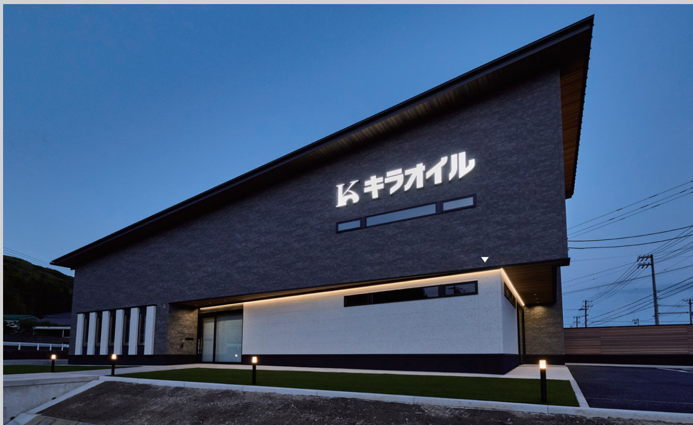
吉良オイルセンター株式会社 本社新築工事 所在地：愛知県 設計・照明設計：ただいま合同会社 一級建築士事務所 施工：長坂建設興業株式会社 写真：新山写真事務所 新山源一郎
