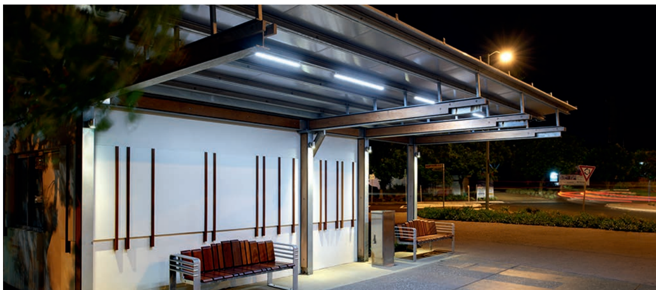
Bus stop Queensland, Australien 写真: Bernie Zajac
