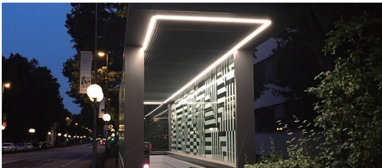
Escalator Roofing, Bonn 設計: Staubach+Kuckertz GbR, HAWART Sondermaschinenbau GmbH 照明設計: Staubach+Kuckertz GbR, HAWART Sondermaschinenbau GmbH クライアント: City of Bonn
